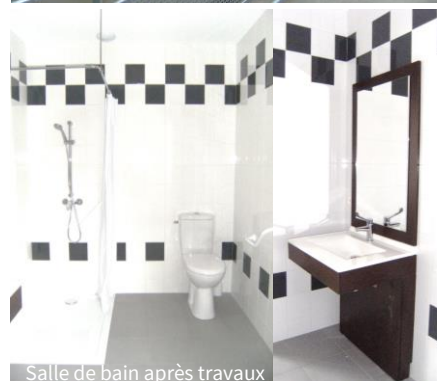
Salle de bain après travaux Exemple : chantier de La Roche Posay
